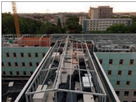
Ala Pediátrica Hospital de São João
